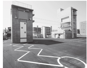
敦賀消防署 消防訓練センター
